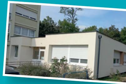
**L'ISOLATION** de l'extérieur et de la toiture de la maison médicale a entraîné une baisse de la facture de chauffage de 27% ! Et de plus, le confort des usagers a été sensiblement amélioré. L'isolation du bâti permet une température plus homogène des locaux !
