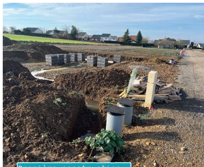
Première construction, "Couronne de Puche"
