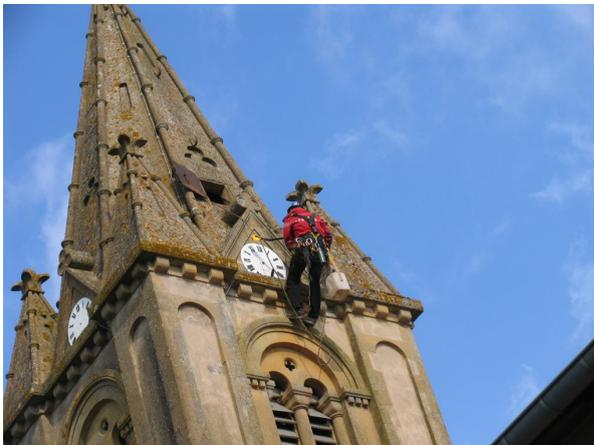
Aussi, pour les faire perdurer, pour éviter que l'usure des battants ne les détériorent, pour que leurs tintements soient toujours purs et limpides, il a été nécessaire d'effectuer quelques travaux, dont l'échange des battants, pesant chacun quelque 40 kg.
